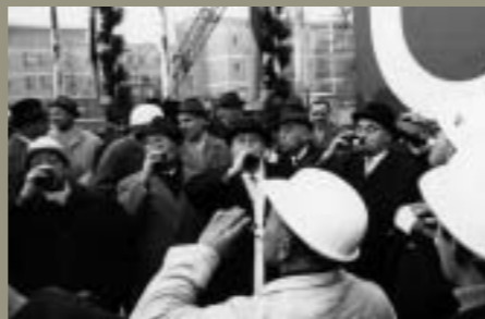
Ein Grund zum Feiern: Am 16. November 1965 fiel der offizielle Startschuss zum U-Bahn-Bau in Hannover (Üstra Archiv)
