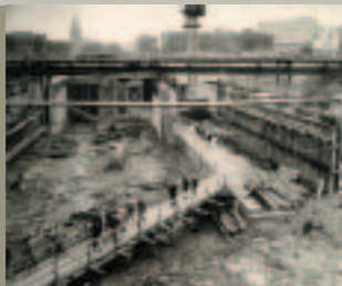
Die Baugrube am Waterlooplatz (Üstra Archiv)
