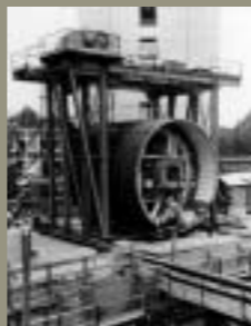
Mit dieser Schildvortriebsmaschine wurde der Tunnel zur U-Bahn-Station Werderstraße gegraben (Historisches Museum Hannover)
