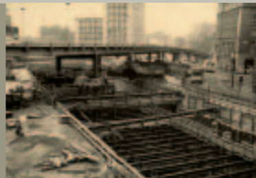
Der Aegidientorplatz während der U-Bahn-Bauarbeiten 1977 (Üstra Archiv / Hauschild?)
