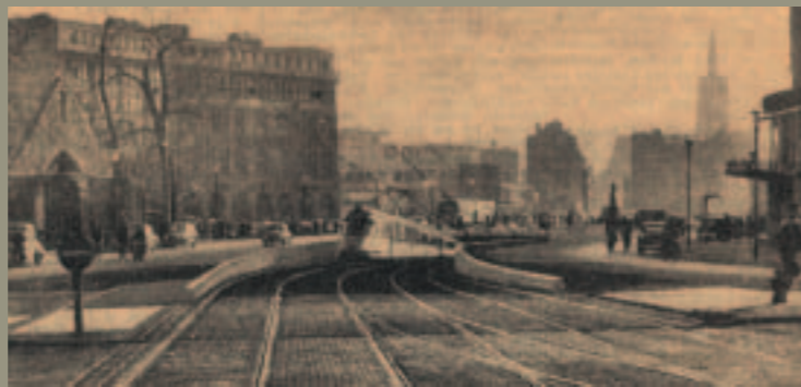
Frühe U-Bahn-Träume der Üstra: Die Fotomontage aus dem Jahr 1954 zeigt, wie eine Unterpflasterstraßenbahn an der Goseriede an die Oberfläche fährt (Üstra Archiv)
