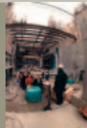
Offene Baugruben folgen dem Straßenverlauf wie hier bei der Strecke C-Nord am Engelbosteler Damm (Üstra Archiv)
