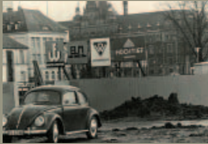
Der Bauzaun steht, die Arbeiten können beginnen (Üstra Archiv)
